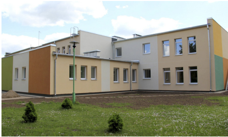
Džūkstes bērnudārza ēka pēc siltināšanas darbiem
