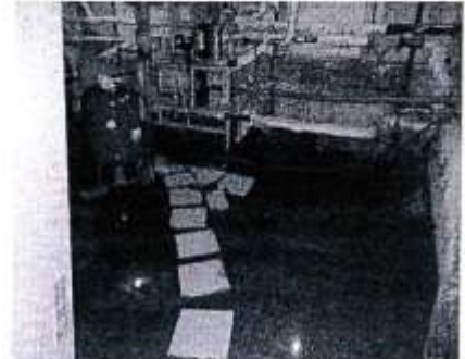
Foto Nr. 2. Lietus un grunts ūdens nonāk pa caurumiem pamatos pagraba telpās. Objekta atkārtotas apsekošanas brīdī pagraba telpās bija sakrājies liels daudzums ūdens.
