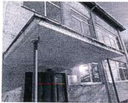
Foto Nr.3. Ir veikts ieejas durvju nojuma armatūras aizsargkārtas remonts.
