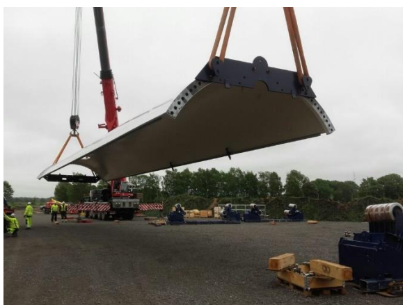
1.4. attēls. Vairāku segmentu VES masta posms (Vestas LDST; http://terralwind.com )
