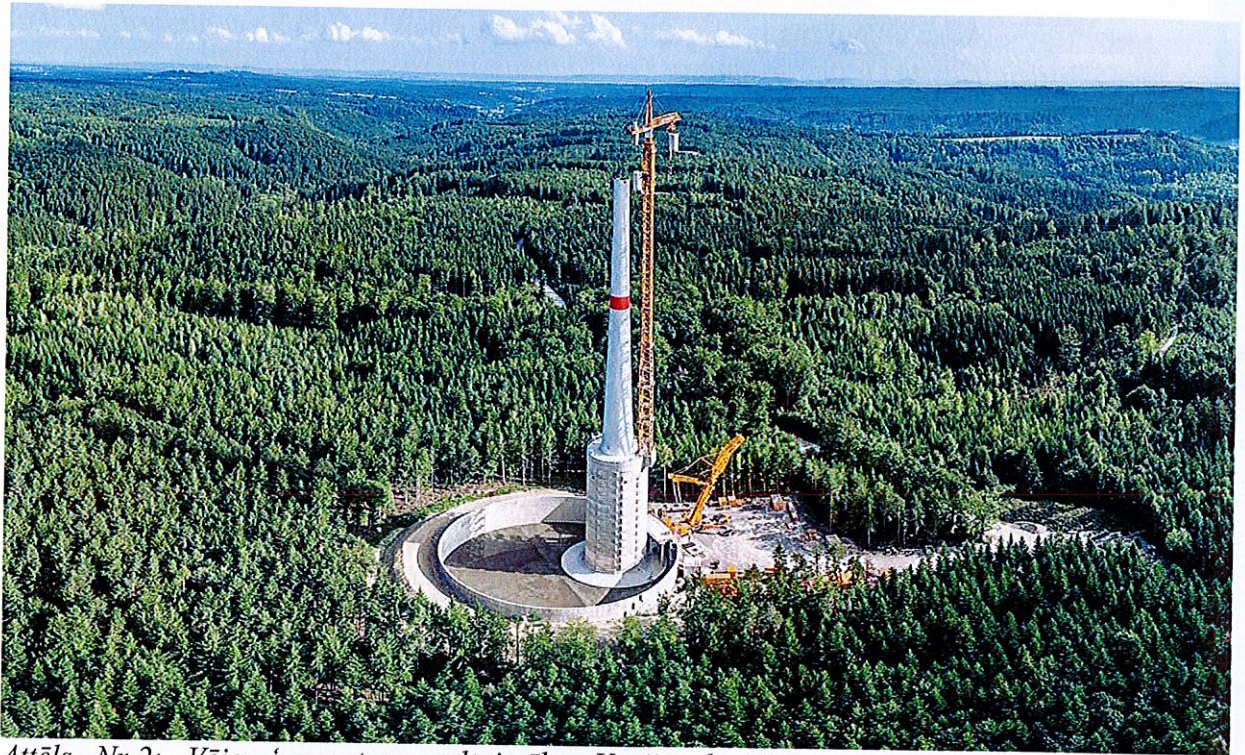
Attēls Nr.2: Vēja ģeneratora celtniecība Vācijā, kopējais augstums pēc būvniecības pabeigšanas 246,5m, avots: https://electrek.co/2017/11/02/worlds-tallest-wind-turbine-built-in-germany/
