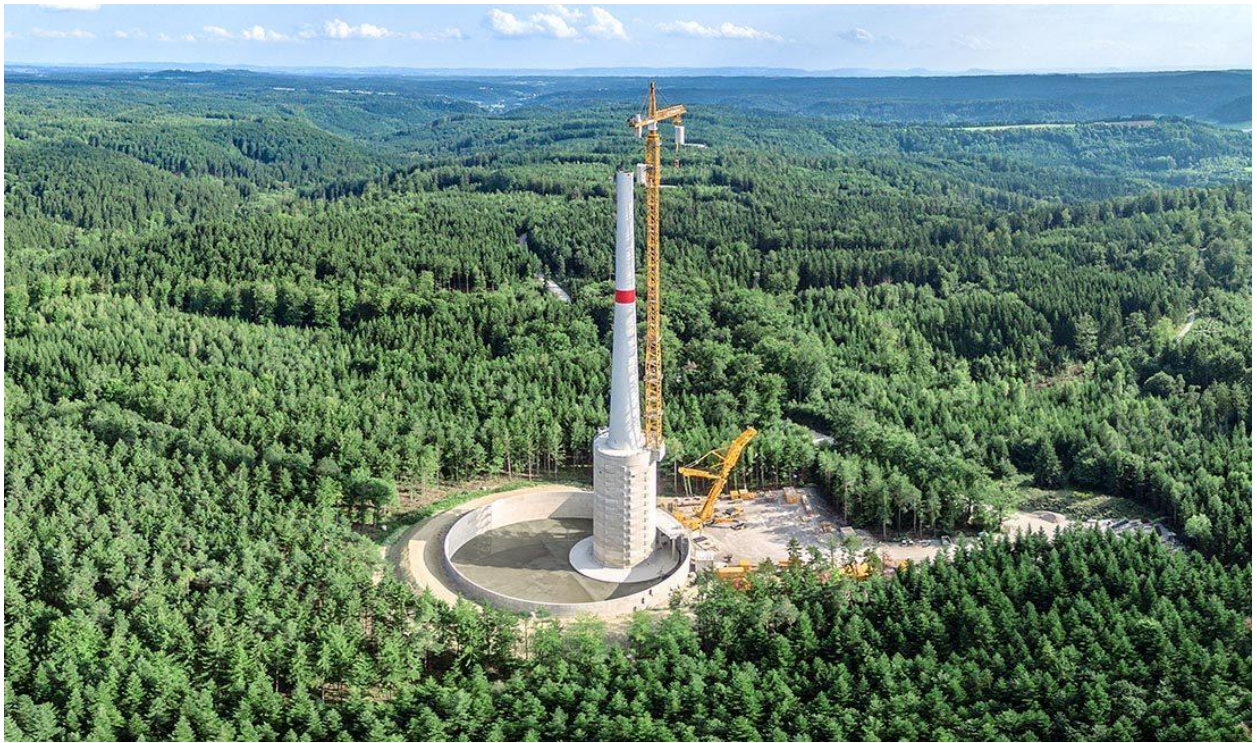
Attēls Nr.2: Vēja ģeneratora celtniecība Vācijā, kopējais augstums pēc būvniecības pabeigšanas 246,5m, avots: https://electrek.co/2017/11/02/worlds-tallest-wind-turbine-built-in-germany/
