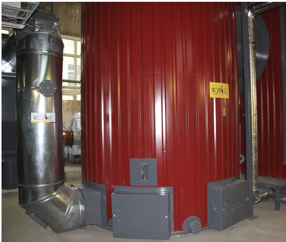
Jaunā ūdenssildāmā šķeldas katla kopējā jauda ir 2MW
