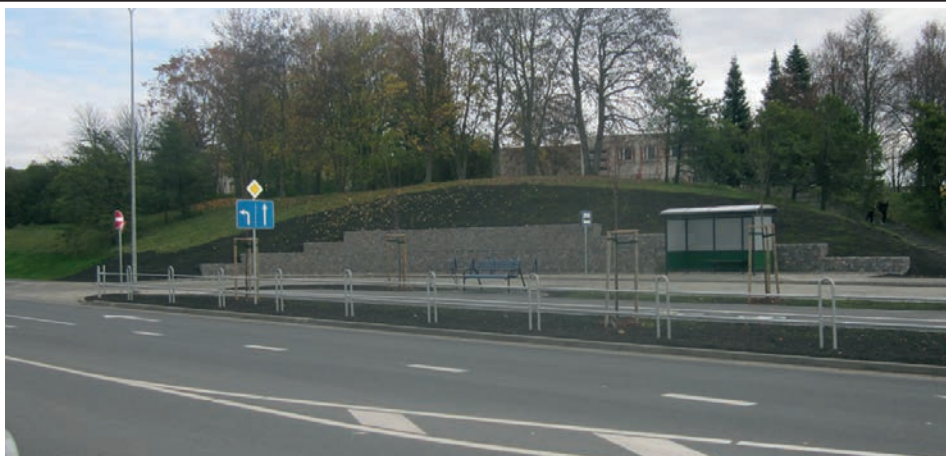
Ekspluatācijā nodots objekts – Zemītes ielas rekonstrukcija un tilta pār Slocenes upi izbūve.
