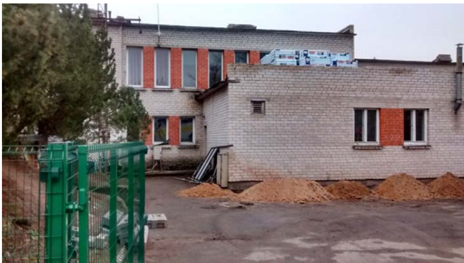
Džūkstes bērnudārzs, uzsākot būvdarbus
