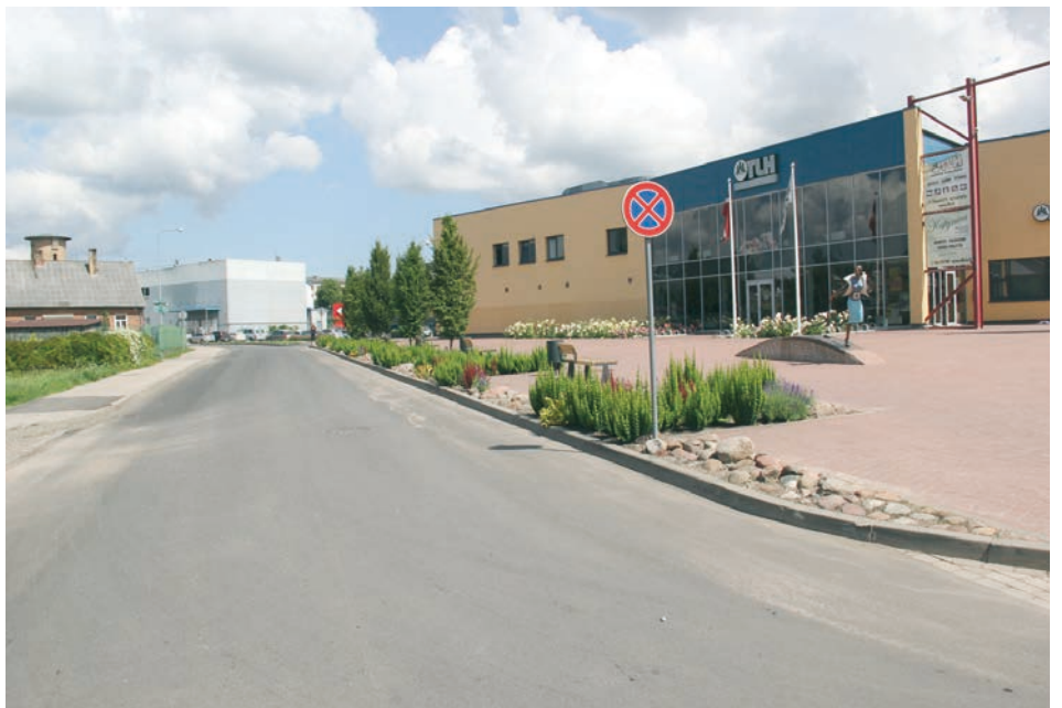
Rekonstruētā brauktuve Stadiona ielā
