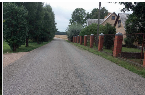
Autoceļa posms Jaunzemji–Graudze ar pretputekļu klājumu
