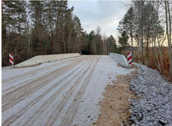
1.25. attēls. Tilts pār Jurģupi
