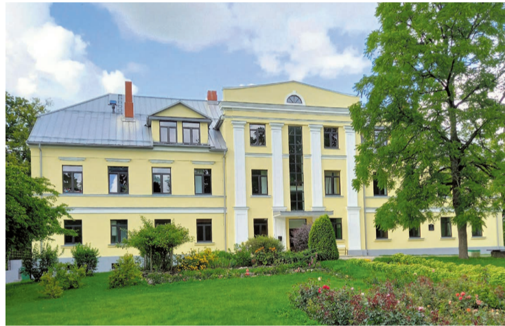
Cēres pamatskolai atjaunots fasādes krāsojums
