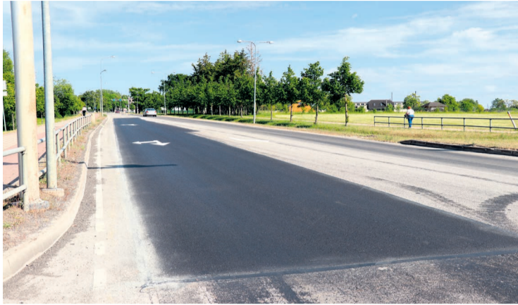
Ceļa seguma atjaunošana bojātajās vietās Jelgavas ielā
