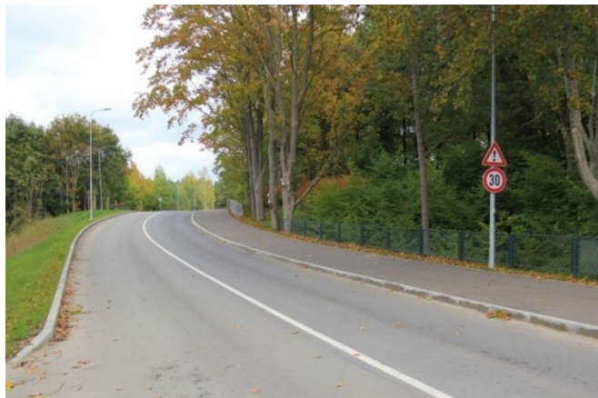
1.12.attēls. Melnezera ielas posma pārbūve.
