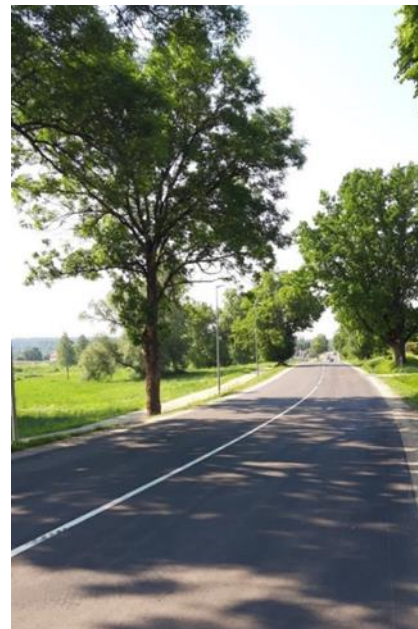
1.13.attēls. Transporta infrastruktūras sakārtošanas darbi Kandavas pilsētā - Abavas ielas posmā, Kurzemes ielā, Meža ielā un Talsu ielas posmā.
