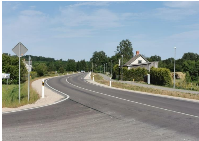
3.19.attēls. Sātos izbūvēts gājēju celiņš ar apgaismojumu.
