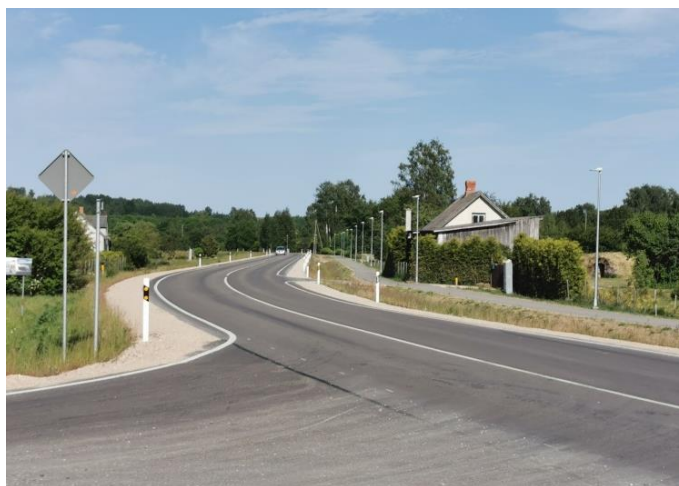
3.19.attēls. Sātos izbūvēts gājēju celiņš ar apgaismojumu.
