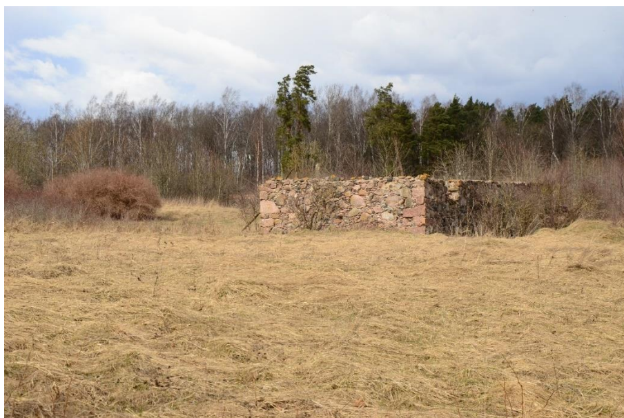
2.18. att. Skats uz apdzīvotās vietas “Cērpji” ēkas drupām (foto J. Jātnieks, 2021)
