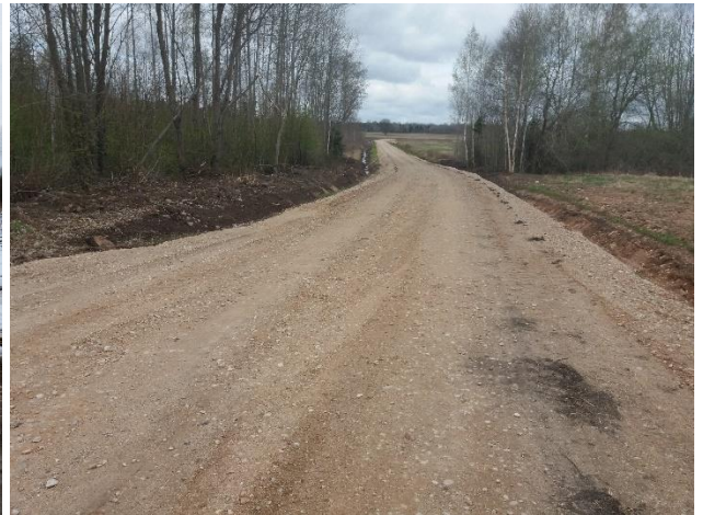
Spirgus-Praviņas ceļa posms pēc būvniecības
