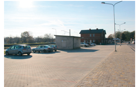
Stāvlaukums dzelzceļa stacijas "Tukums I" teritorijā
